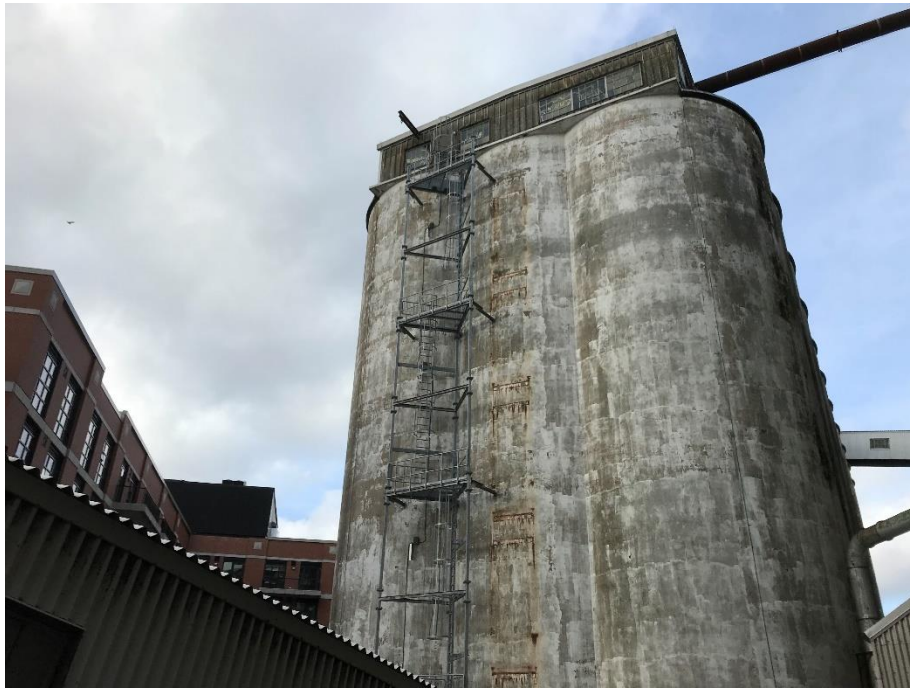
D.3: Exterior of Annex 4 silos.
