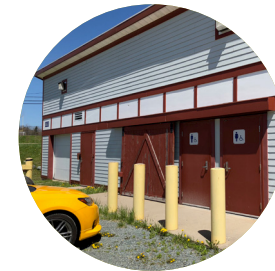
FIGURE 20. Cole Harbour Commons
